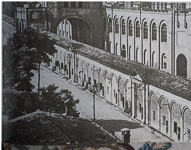
Foto n. 55. Alloggi di fortuna ricavati dai portici dello Stadio
