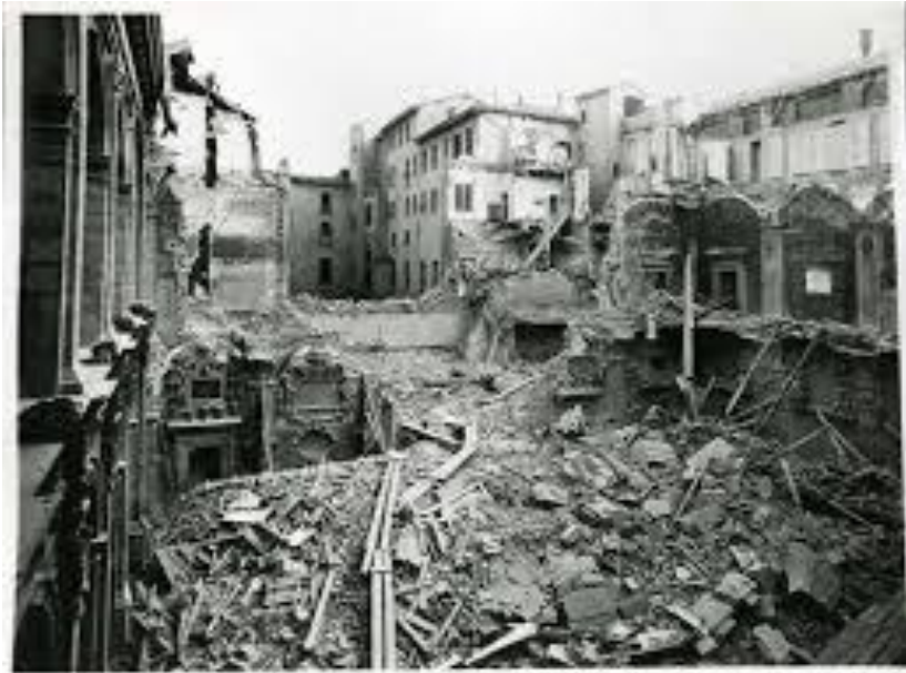
Foto n. 79. Macerie e grondaie di case bombardate
