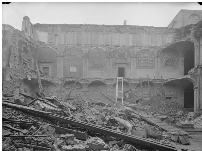
Foto n. 22. La distruzione dell'Archiginnasio
