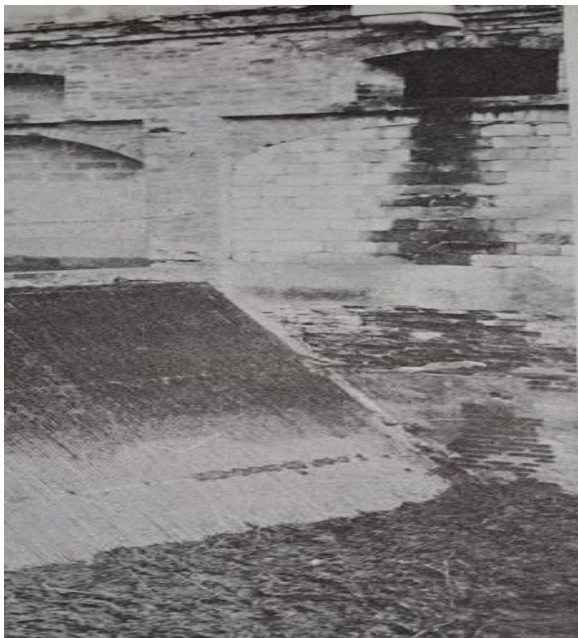
Foto n. 40. La vasca di decantazione del Canapificio, detta “Botte”.
